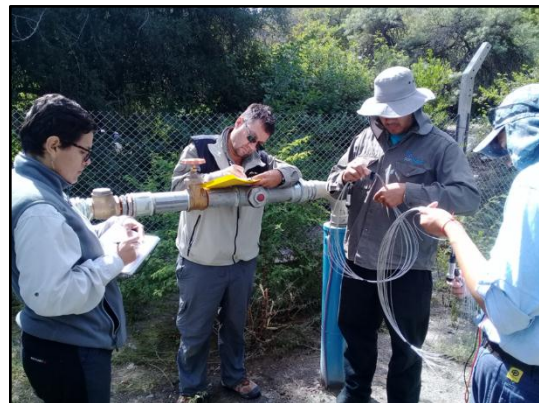
Figura 4. Instalación del diver en la perforación.
