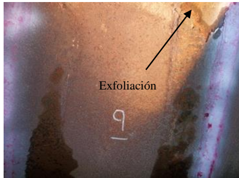
Figura 10. Sector inferior izquierdo del álabe N° 9 con exfoliación
