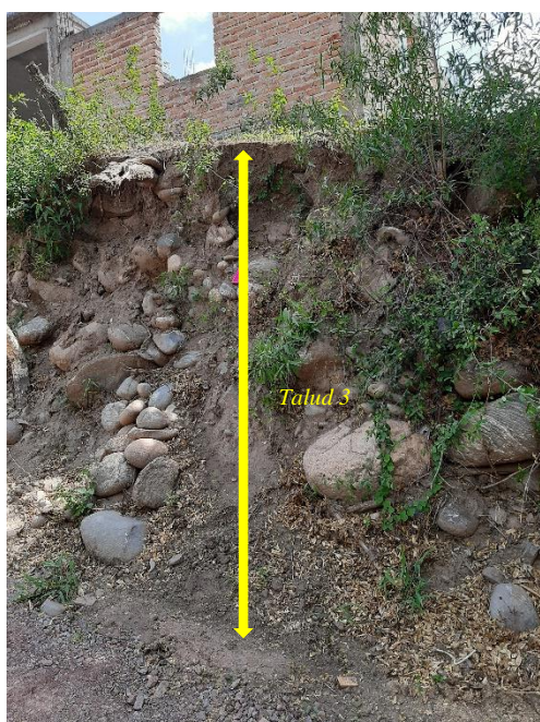
Foto 4. Talud 3. Límite entre las unidades geomorfológicas Terraza inferior y Área de Interfluvios.
